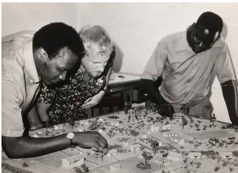
Kuva 1. Rakennusinsinööri Erkki Laitinen työskenteli Tansaniassa Suomen toisessa kehitysjoukossa vuosina 1970–1972. Kuvasta kerrotaan kansanedustaja Reino Breilinin kirjoittamassa artikkelissa sosiaalidemokraattisessa Eteenpäin-lehdessä 7.2.1973 seuraavaa: ”Hänen toimipaikkansa oli maaseutukehityksen ministeriön piirustuskonttorissa, jossa hän suunnitteli rakennuksia ujamaa-kyliin ja maaseudun koulutuskeskuksiin. Vincent Paul Kyauka (vas.) ja Ahmed Mkallah toimivat hänen assistentteinaan. Kuvassa näkyy työryhmän itsenäisyyden kymmenvuotisjuhla varten rakentama ujamaa-kylien pienoismalli. Kuva: Ulkoministeriön arkisto, kuva- ja lehtileikekokoelma, Helsinki / kuvaaja tuntematon.
