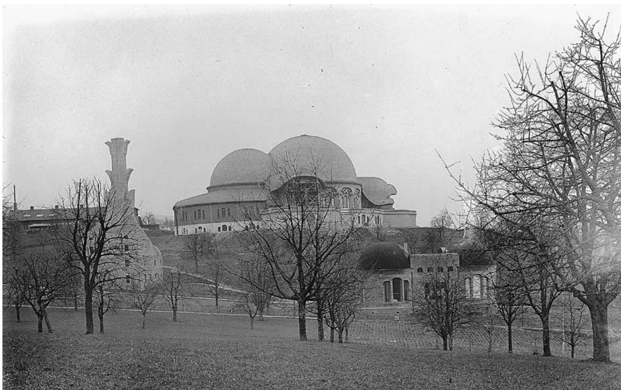
Kuva 2. Ensimmäinen Goetheanum, etualalla lämpövoimala ja Lasitalo. Kuvattu pohjoisesta. Kuva: Staatsarchiv Basel-Stadt, NEG 1804, kaikki oikeudet pidätetään.
