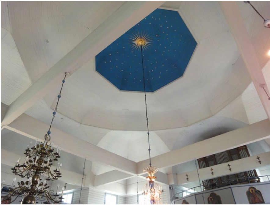
Kuva 1. Lappeen kirkko, välikattoholvin kupu ja vetoparruja. Kuva: E. M. Viljo 2012, kaikki oikeudet pidätetään
