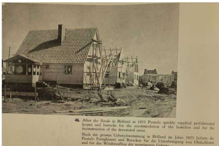
Bild 5–6. De 13 finländska bostadshus som Myyntiyhdistys Puurakenne sände till Nieuwe-Tonge i Holland år 1953 presenteras i ett flertal artiklar i samband med att byggnaderna sändes iväg och byggdes upp på plats. I Puutalo Communications 1 år 1957 presenteras byggnaderna som tillverkade av Puutalo Oy.
