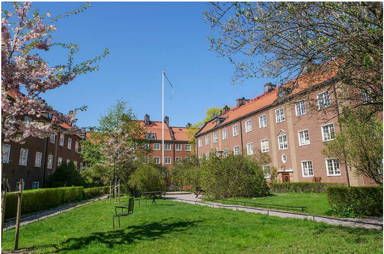
Bild 6. Grön innergård med entréer mot gården, Kvarteret Motorn, SKB. Arkitekt Gustaf Larsson, 1917. Foto Jan Rydén Bonmot, 2021, alla rättigheter förbehållna.
