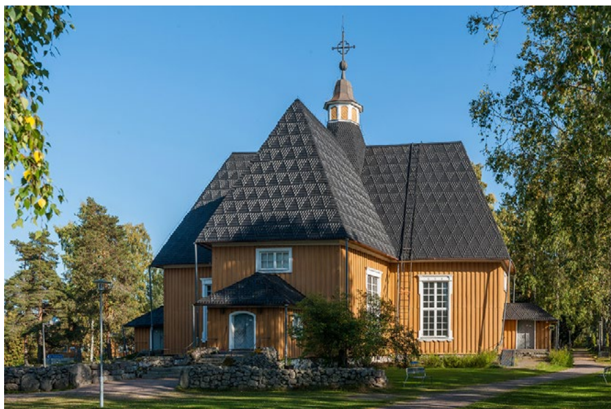
Kuva 2. Lemin kirkko on samaa tyyppiä kuin monet luovutetulla alueella olleet ristikirkot. Sen torni on kuitenkin rakenteellisesti kehittyneempää mallia. Kuva: Tuomas Vitikainen 2017. Lähde: Wikimedia Commons, lisenssi CC BY-SA 4.0.
