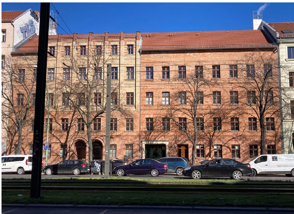
Kuva 6. Ainoat säilyneet Berliinin yleishyödyllisen rakennusyhtiön 1850-luvulla rakennuttamista asuinkerrostaloista sijaitsevat Berliinissä osoitteessa Torstraße 85–87. Kuva Teppo Jokinen 2025, kaikki oikeudet pidätetään.
