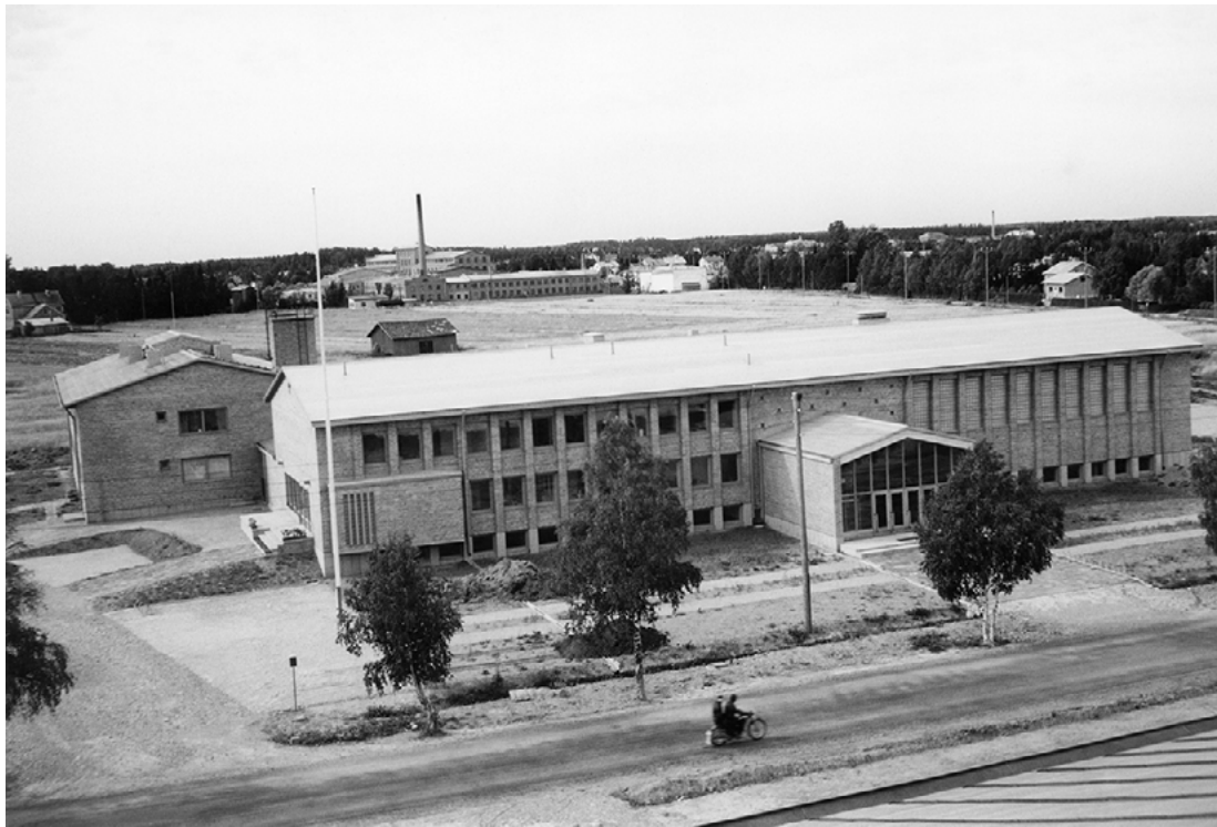
Kuva 1. 1950-luvulla rakennettu Tikkurilan kirkko, yksi harvoista Tikkurilan keskustan suojelluista rakennuksista, purettiin 2010-luvulla kiinteistökehityshankkeen tieltä. Kuva: Vantaan kaupungin-museo / Mauno Mannelin 1957. Lähde: finna.fi, lisenssi CC BY 4.0.
