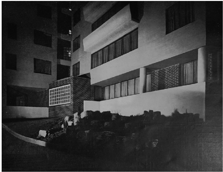
Kuva 17. Architectural Review -lehden valokuvaajat Dell & Wainwright käyttivät kuvatessaan voimakasta lisävalaistusta ja jälkikäsittelyä. Mark Oliver Dell ja H. L. Wainwright. Valokuva Berthold Lubetkinin suunnittelema Highpointin asuintalosta (1933–1935), Architectural Review (7) 1935. Kuva: Maikki Salmi-nen, CC BY 4.0.
