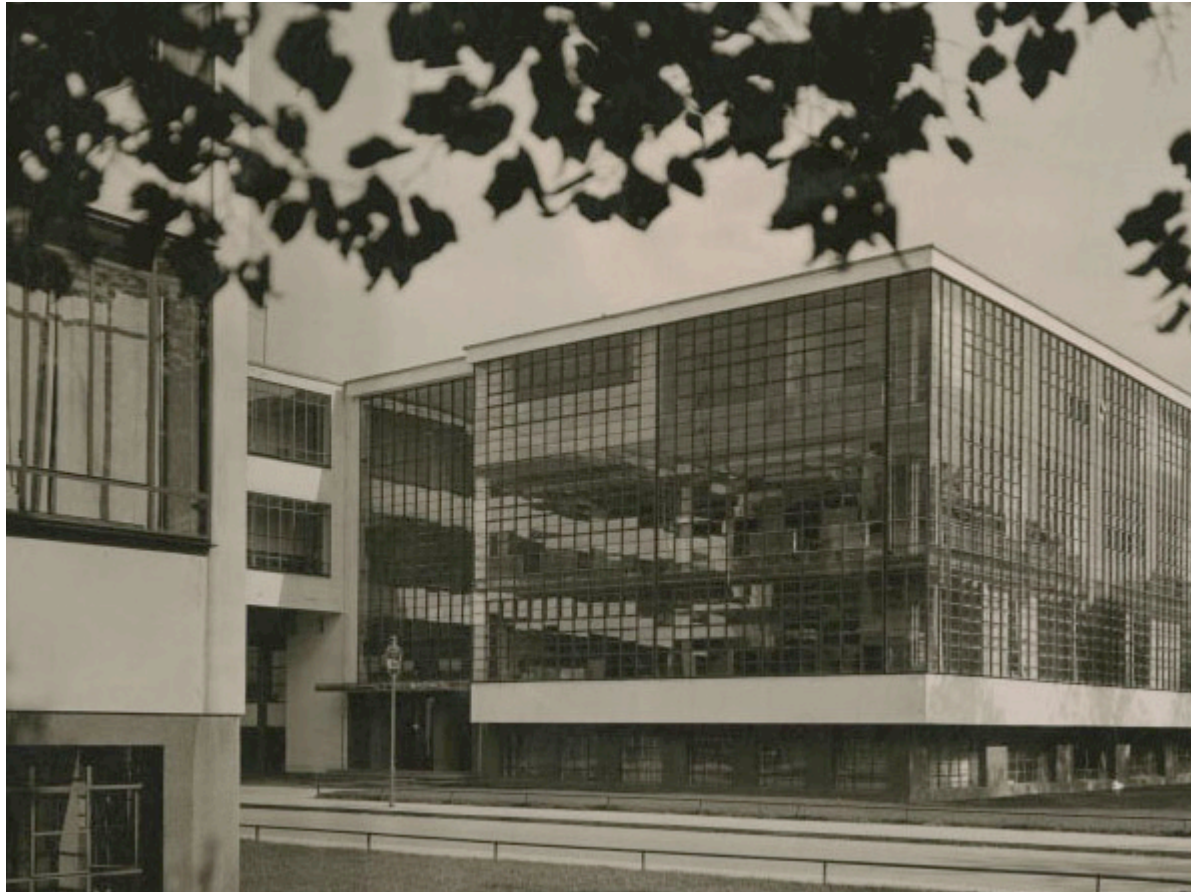
Figure 3. Walter Gropius, Bauhaus Building Dessau, 1925-1926, entrance and workshops. Bauhaus Archiv - Museum für Gestaltung Berlin.
