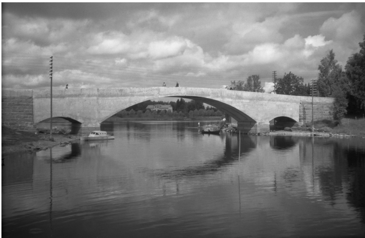
Kuva 3. Vuonna 1919 valmistunut Mierolan silta Hämeenlinnan Hattulassa. Mierolan sillan suunnitteli ja toteutti Oy Constructor Ab, jonka muihin tunnettuihin teräsbetonisiltoihin kuuluivat mm. Tampereen kiviverhoiltu Hämeensilta ja Kouvolan Korian rautatiesilta. Paljon kuvatun sillan suunnittelijaksi arvellaan Wäinö Wuoliota, mutta paremmin tiedossa on sen ulkoasun suunnitellut Frosterus-Gripenbergin arkkitehtitoimisto. Kuva: Matti Poutavaara 1919. Lähde: Finna.fi .
